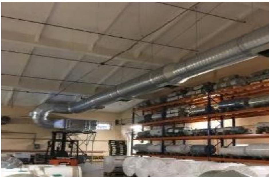
Рисунок 3 – Приточно-вытяжная вентиляция
