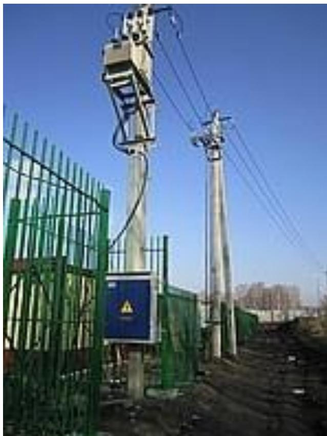
Рисунок 1 – Внешний вид столбовой трансформаторной подстанции
